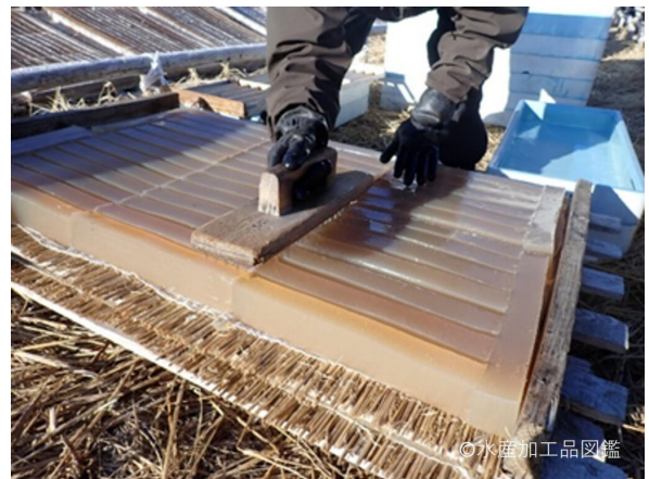
写真13 ザクによる生天への釘刺し (提供：川之辺素一)
